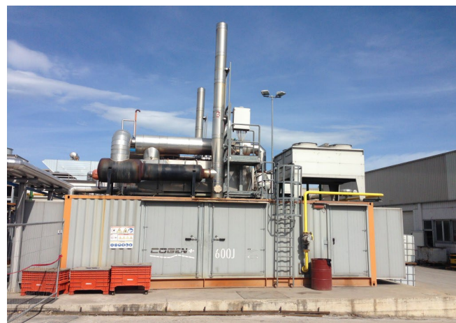
Il nostro tri-generatore
